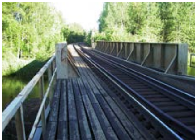
Järnvägsbron över Testeboån.
